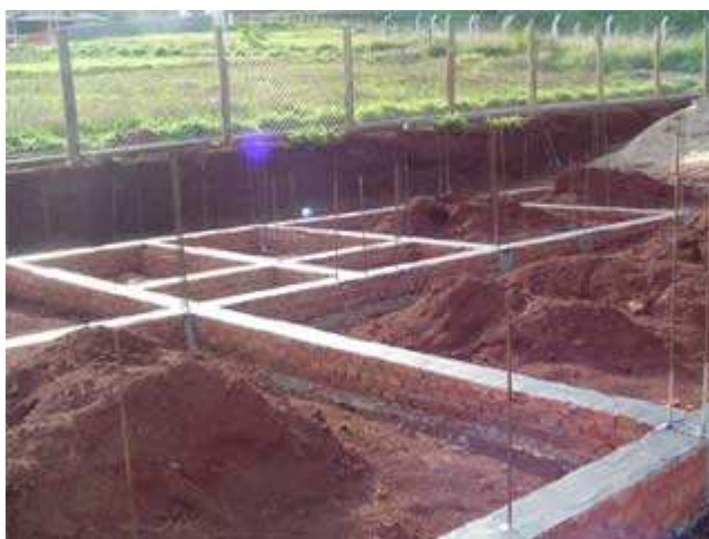
Figura 1 – Alicerce/fundação Fonte: TIJOL-ECO
