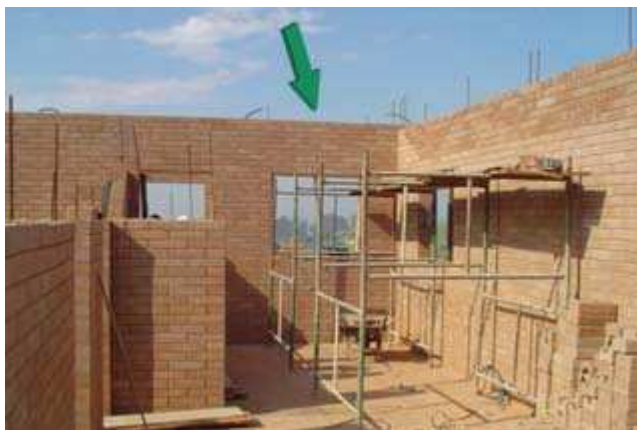
Figura 3 – Cintamento da construção Fonte: TIJOL-ECO
