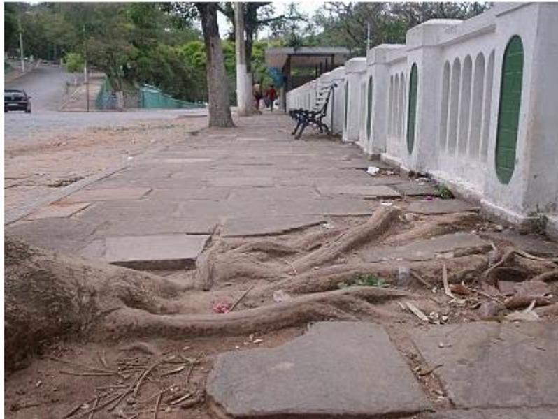
Figura 17 – Calçada danificada por raízes
