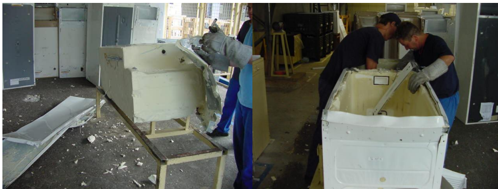
Figura 9 - Desmontagem e seleção das peças dos refrigeradores Fonte: (COMPANHIA ENERGÉTICA DE ALAGOAS - CEAL, [200?])
