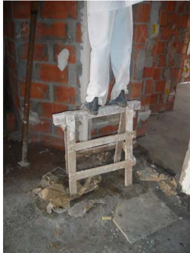
Figura 9 - Cavalete sendo utilizado de forma insegura Fonte: SESI
