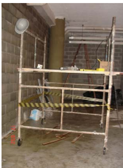
FIG. 17 – Andaime móvel disposto de forma irregular e sem dispositivo trava rodas.
