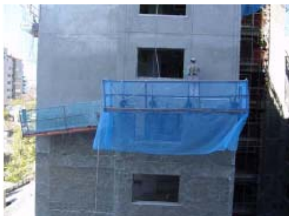
Figura 5: Vista frontal de um andaime leve (à esquerda) e de um pesado (à direita). Fonte: UFRGS
