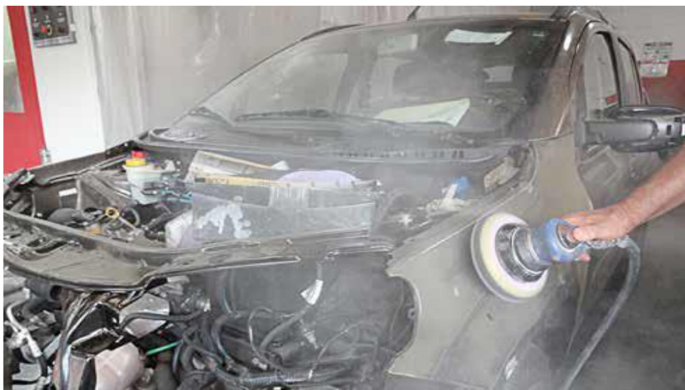
Figura 2 – Emissão de particulados na etapa de lixamento Fonte: (FEAM, 2016).
